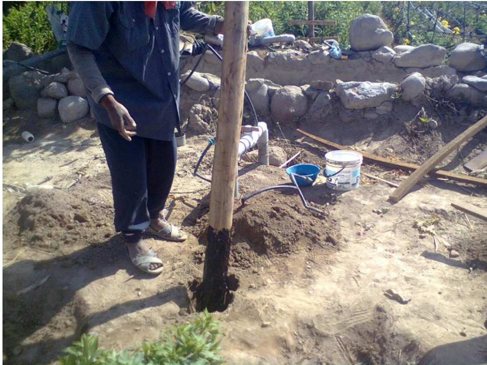
FOTO 5: Colocación de postes
