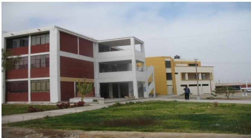
Figura N° 28: Vista Frontal de la E.A.P. de Obstetricia
