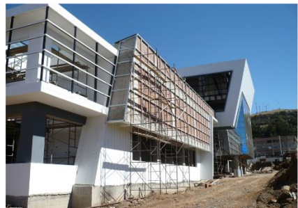
VISTA DE CONSTRUCCIÓN ACTUAL DEL PROYECTO
