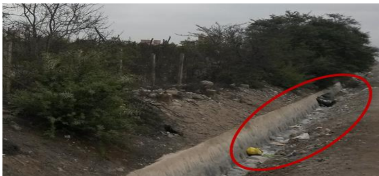
Figura N° 63: Vista Actual del Canal Uchusuma
