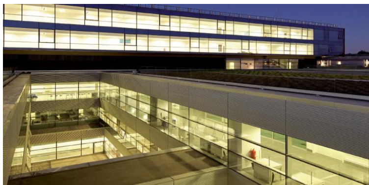
Figura 6 Hospital del Carmen - Maipú vista interna
