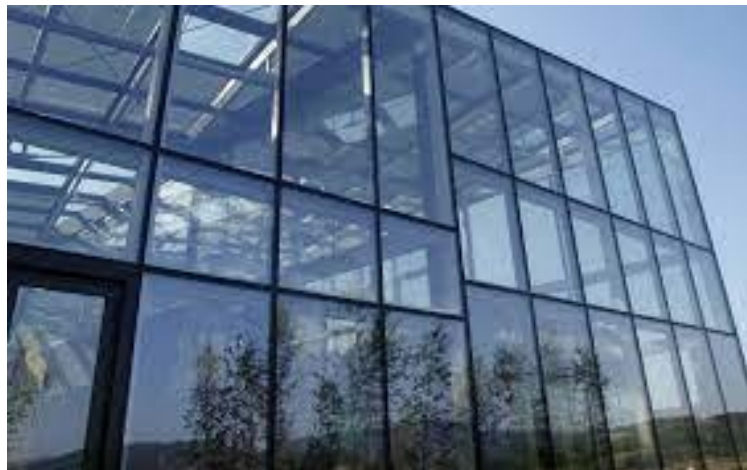
Figura 77 Muros cortina en fachada
