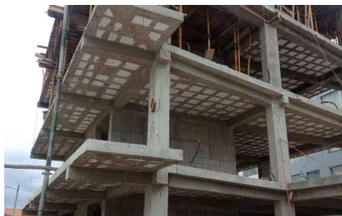
Figura 70 Sistema aporticado en edificaciones
