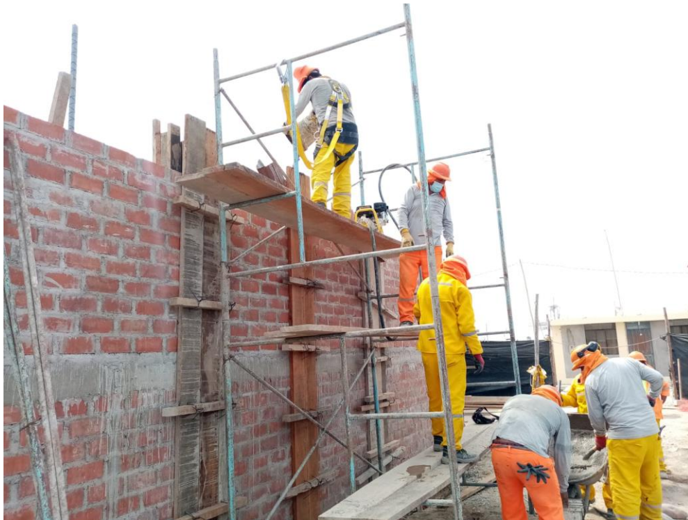
Fotografía 6. Vaciado y vibrado de concreto en columnas del bloque A
