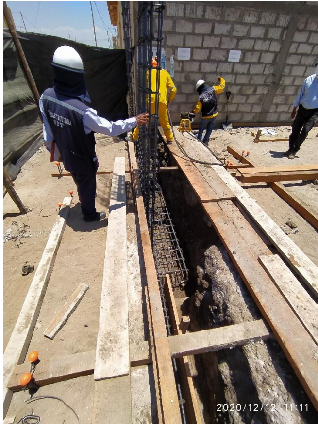
fotografía 3. Vibrado de concreto en la zapata corrida del bloque A
