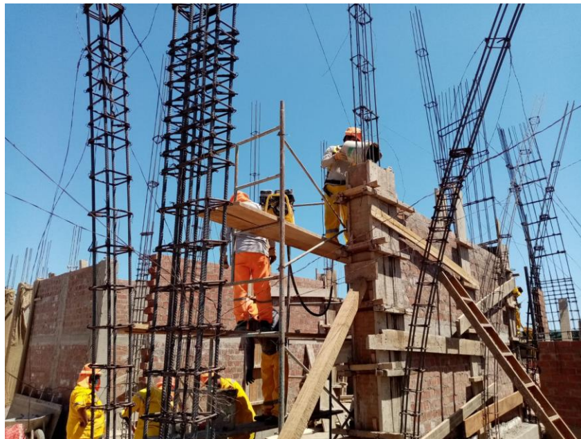
Fotografía 8. Estructuras de acero de columnas y placas en el bloque A
