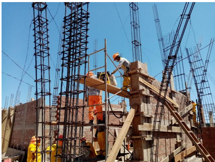
Fotografía 9. Vaciado de concreto en columnas y viguetas del bloque A
