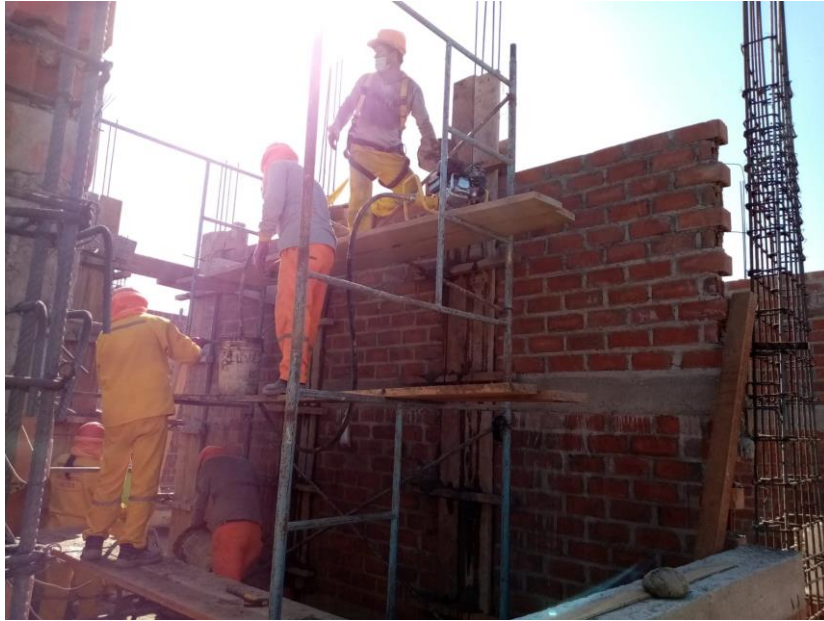
Fotografía 7. Traslado del concreto F'c: 210 \text{ kg/cm}^2 para el vaciado de columnas
