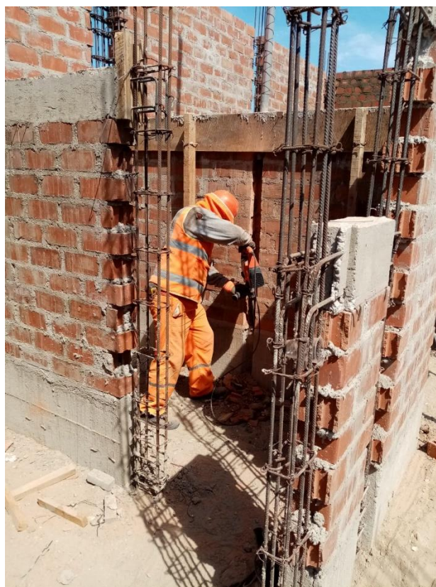
Fotografía 10. Preparación de salidas de instalaciones eléctricas y sanitarias
