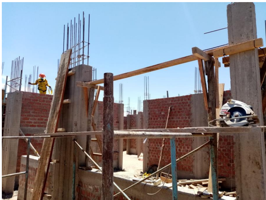
Fotografía 4. Desencofrado de columnas en el bloque A
