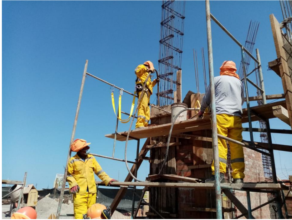
Fotografía 5. Vaciado de concreto en placas del bloque A
