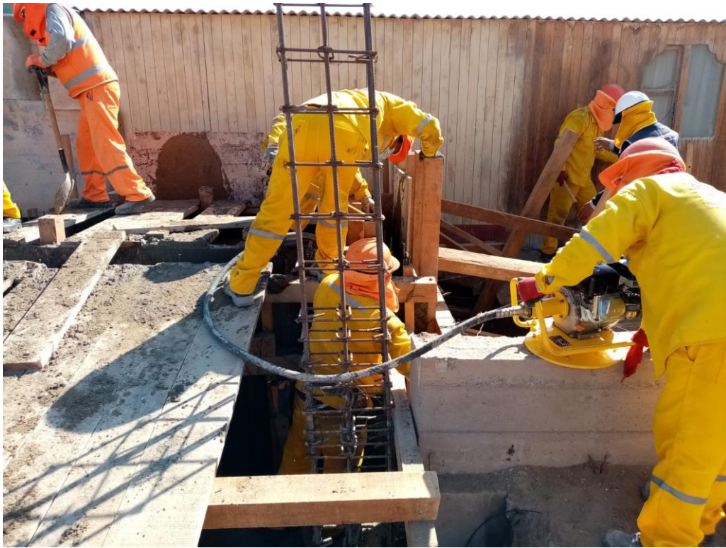
Fotografía 11. Vaciado y vibrado de los sobrecimientos en el bloque C
