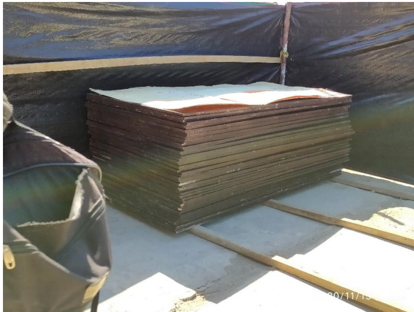
Fotografía 1. Inventario de triplay fenólico para los encofrados
