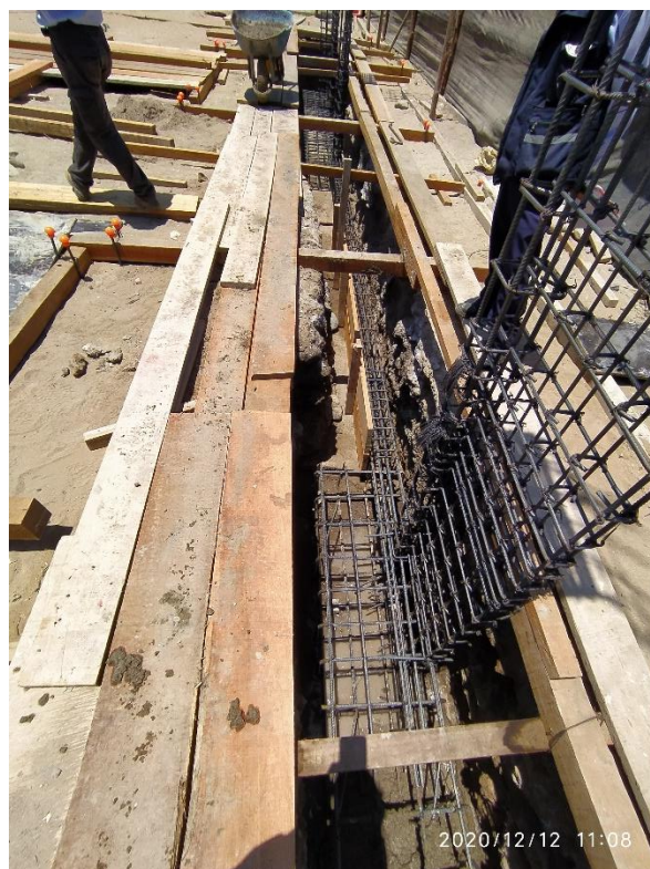
Fotografía 2. Inicio de vaciado en zapata corrida del bloque A
