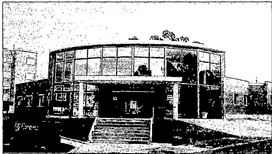
Fotografía N° 13: Fachada principal del edificio
