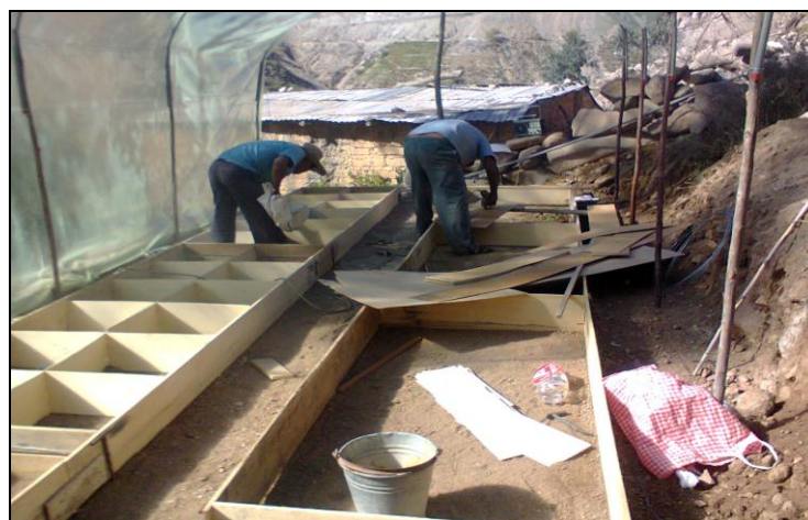
Foto n° 01: Construcción del Invernadero Rural
