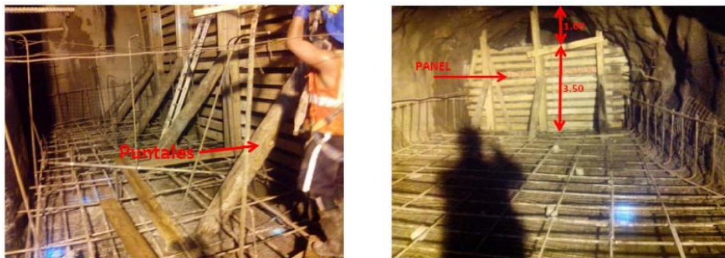
Figura 5. Encofrado o tabique actual de las losas.
