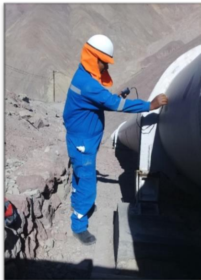
Figura 29 Medición de espesor
