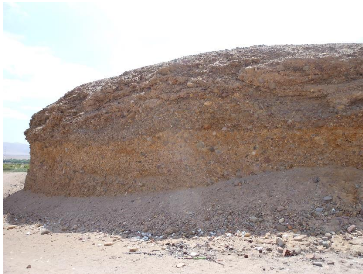
Figura 4. Vista de grietas en laderas escarpadas propicio como refugio de murciélagos en cerca al poblado de la localidad de Tomasiri
