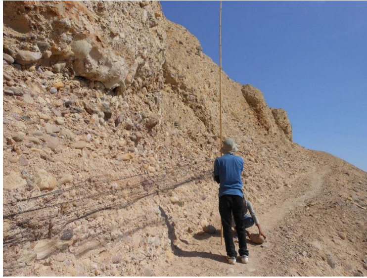
Figura 13. Instalación de redes de niebla en laderas escarpadas
