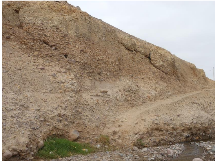
Figura 3. Vista de grietas en laderas escarpadas propicio como refugio de murciélagos en la localidad de Tomasiri
