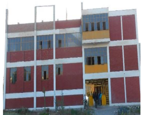
Figura 28. Elevación posterior del edificio.
