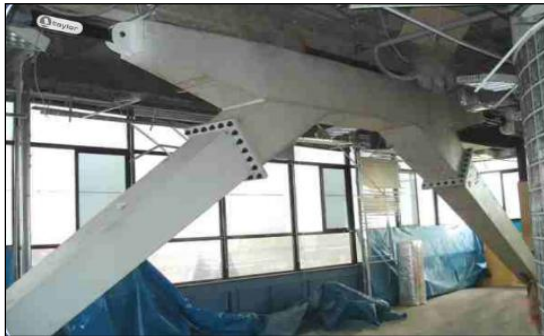
Figura 18. Disipadores en aeropuerto Jorge Chávez. Fuente: CDV, Lima Perú.
