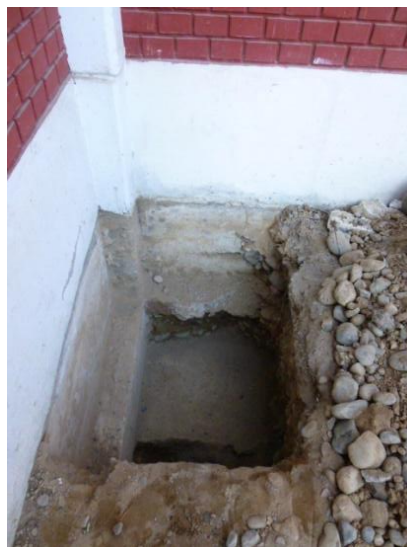
Figura 29. Zapata en Intersección, eje A – 7.
