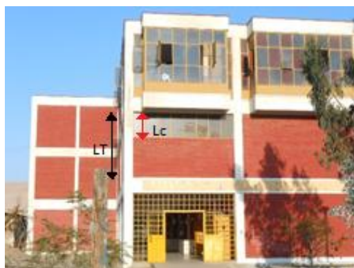
Figura 53. “Lt” y “Lc” en Columna corta.
