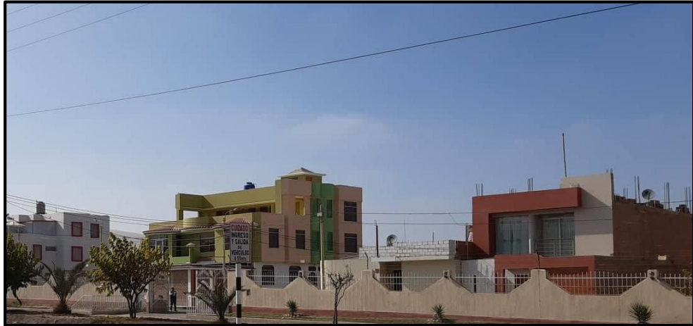
Figura 31. Edificaciones de albañilería confinada.
