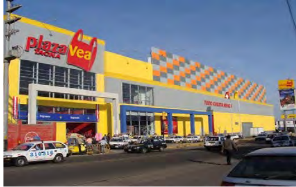
FIGURA N°45 VISTA FACHADA PRINCIPAL DE PLAZA VEA
