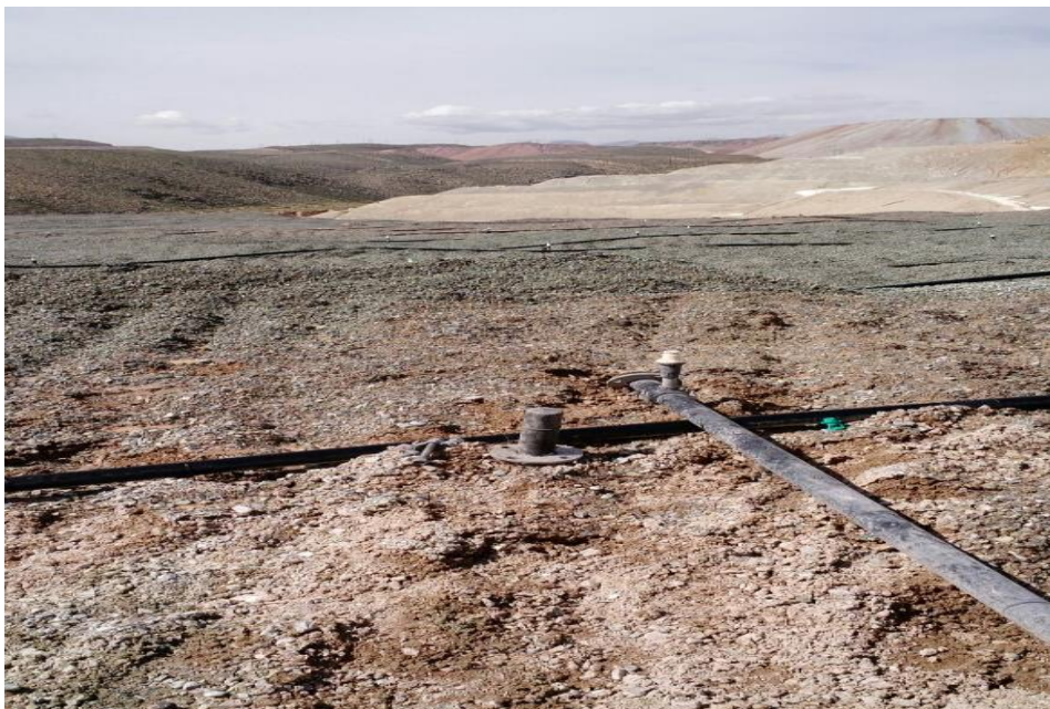
Figura 22. Instalación de líneas de riego Fuente: SPC - Cuajone
