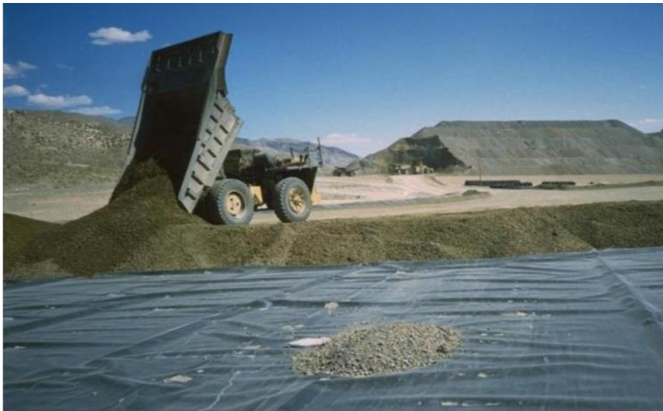
Figura 21. Apilamiento del mineral Fuente: Hidrometallurgy
