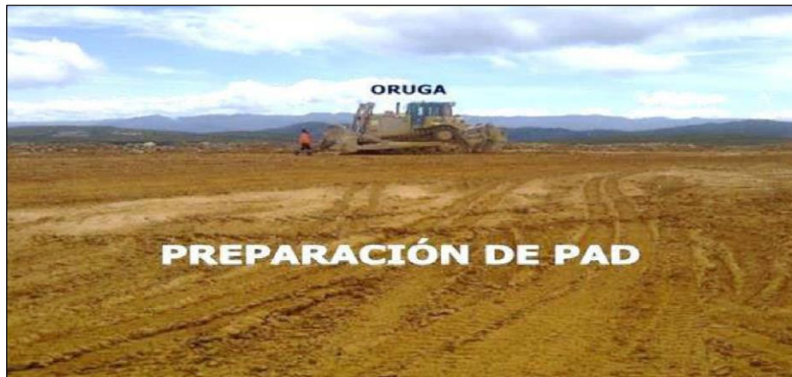
Figura 20. Preparación del PAD Fuente: Cía Minas Buenaventura
