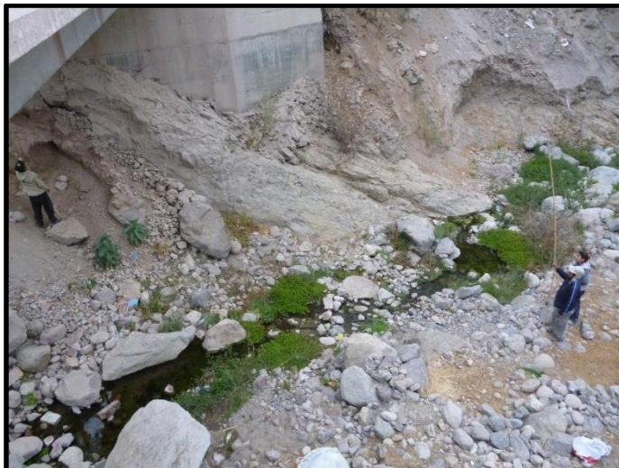
Foto 26. Instalación de red de niebla bajo un puente vehicular en la localidad de Borogueña.
