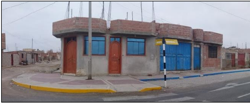
Figura 59. Edificación de albañilería confinada
