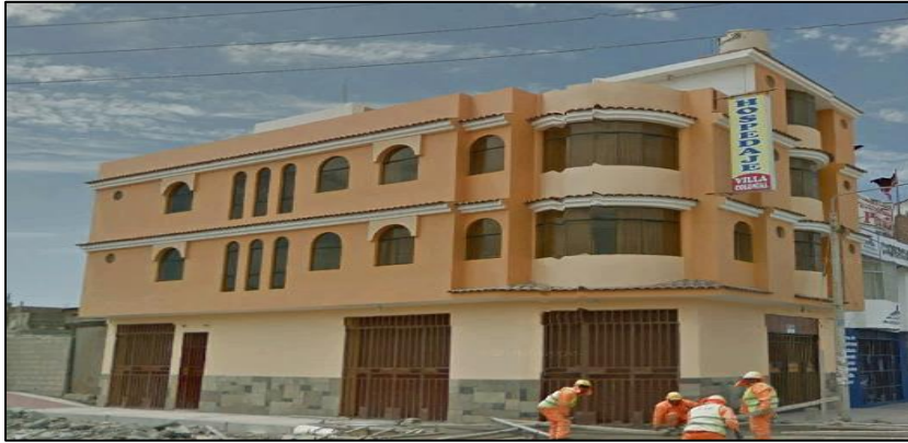
Figura 60. Edificación con sistema aporticado
