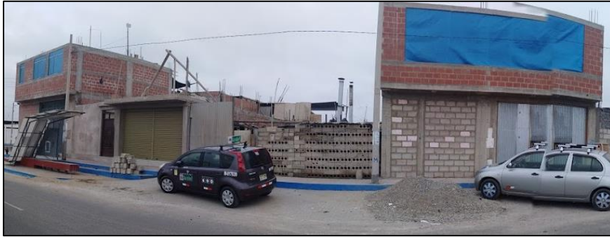
Figura 48. Edificación con ladrillo y bloque de cemento
