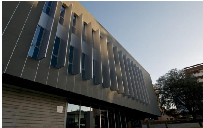
Figura N°6: Fachada del Edificio de la Guardia de Lleida
