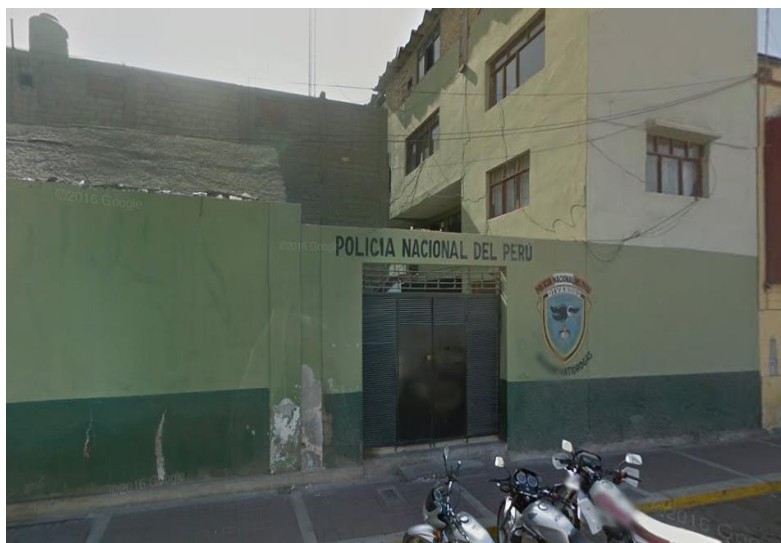
Figura N°46: Edificación Actual de la División Protección Ambiental
