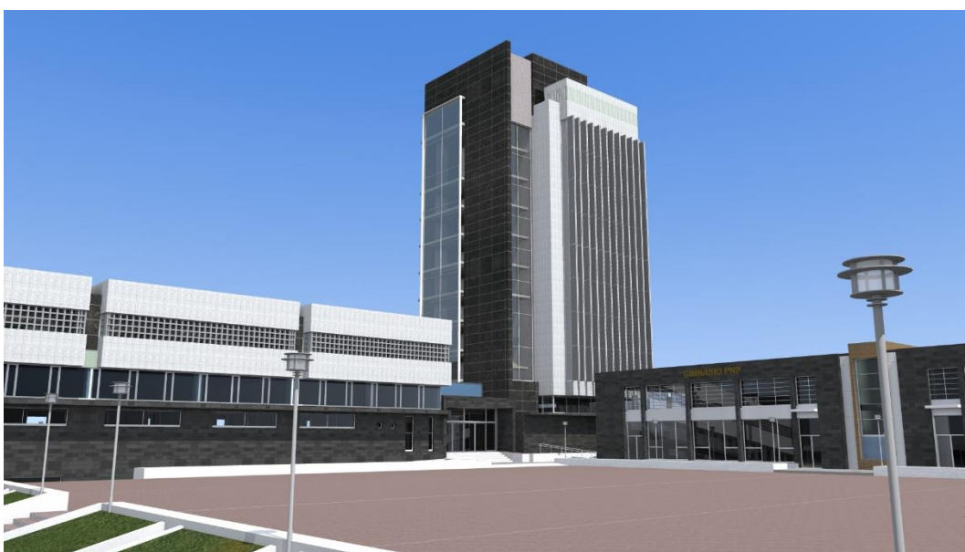
Figura N°127 Vista Posterior del edificio DIRTERPOL Tacna
