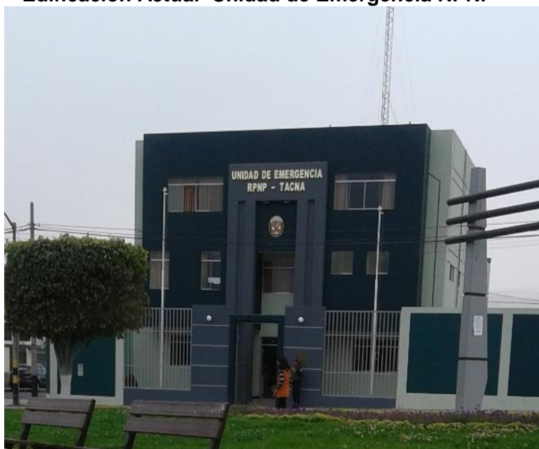
Figura N°40 Edificación Actual Unidad de Emergencia RPNP
