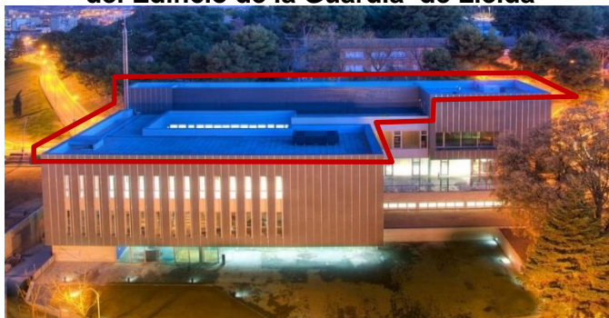
Figura N°7: Cubierta del Edificio de la Guardia de Lleida
