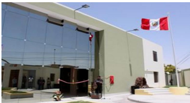
Figura N°38 Edificación Actual Laboratorio de Criminalística
