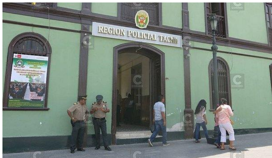
Figura N°35 Edificación Actual Región Policial de Tacna
