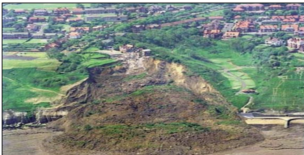
Figura 5. Deslizamiento rotacional de Holbeck al sur de Scarborough (UK) en 1993. Afectó a un hotel, pero no hubo víctimas mortales porque los huéspedes fueron desalojados con anterioridad. (Por cortesía del Servicio Geológico Británico http://www.bgs.ac.uk/landslides/holbeckHall.html ).
