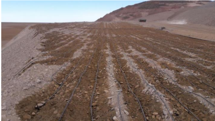
Figura 8. Apilamiento de mineral en el pad piloto y distribución del sistema de riego Fuente: Recolección propia
