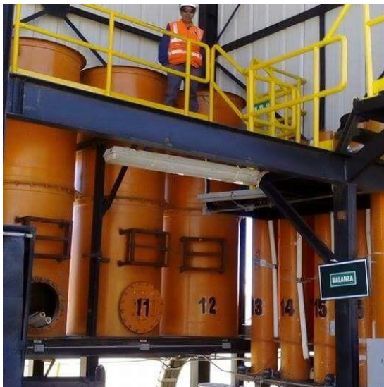
Figura 6. Columnas, 76 cm diámetro x 294 cm altura, para las pruebas de lixiviación
