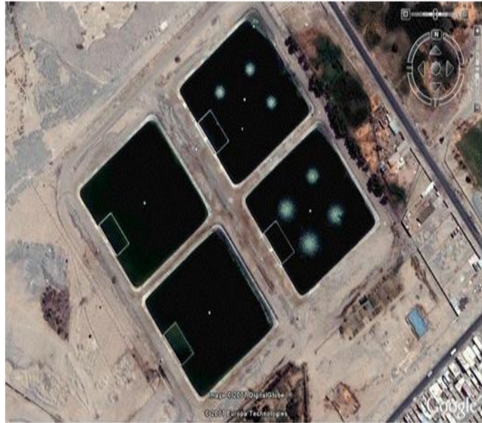
Figura 17. Vista satelital de la PTAR Copare (Cono Sur).
