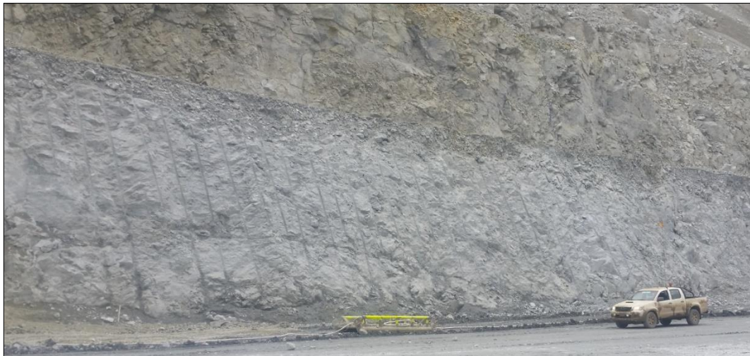
Figura 37. Talud pre corte Fuente: SPCC, 2018.
