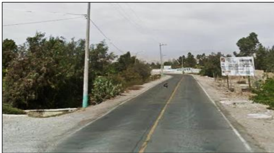
Figura N° 34. Estado actual de la vía Tacna-Calana-Pachía Fuente: Google Maps
