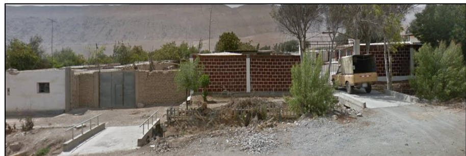
Figura N° 31. Estado de edificación regular
