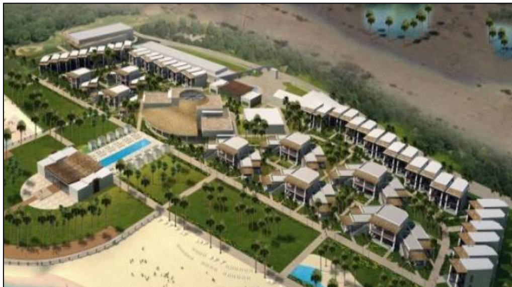
Figura N° 7. Vista aérea del Hotel Libertador, Pisco- Ica
