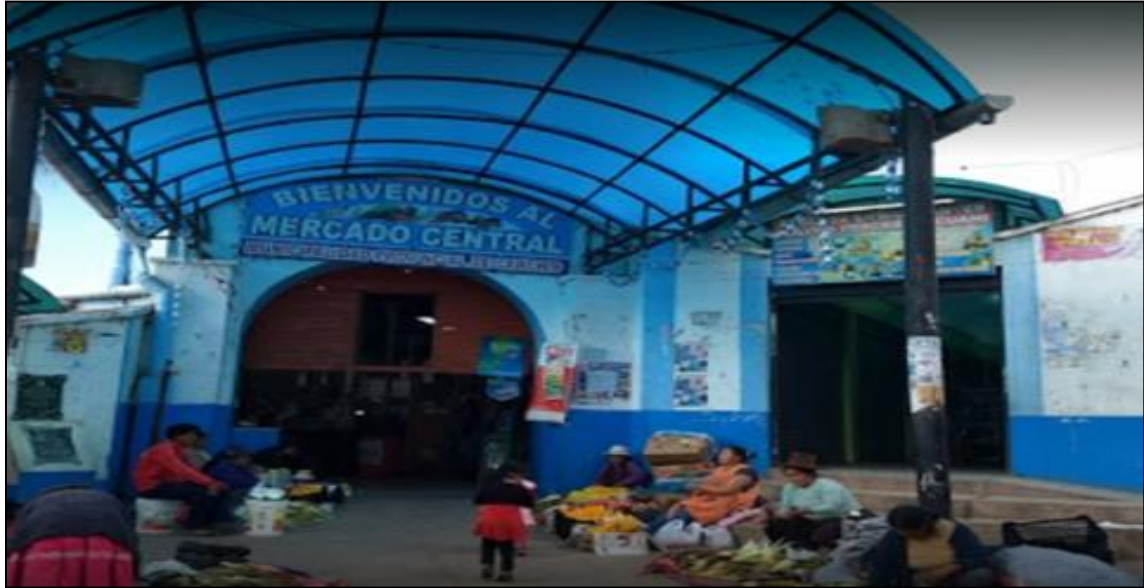
Foto 1: Vista del ingreso principal en el mercado central de Sicuani.
