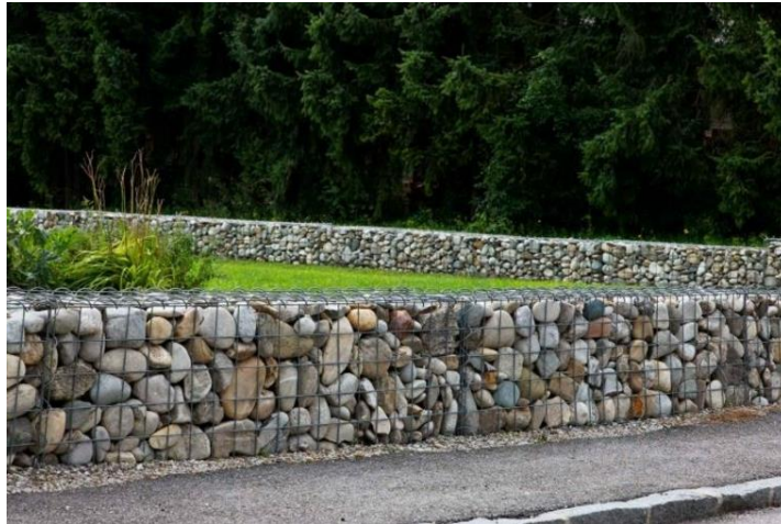
Figura 66: Muro de gavión
