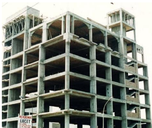
Figura 64: Sistema aporticado en la construcción de edificaciones
