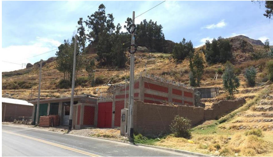
Figura 60: Colindante Norte del Terreno propuesto
