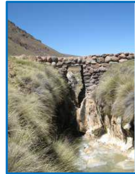
Figura 26: Puente de Piedra. Fuente: Elab. Propia.
