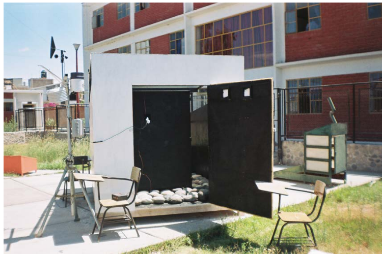
Figura 48: SSS como acumulador térmico la piedra sin pintar.
