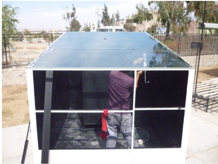
Figura 25: Colocado de la cubierta transparente. Fuente: Archivo propio. (2012)
