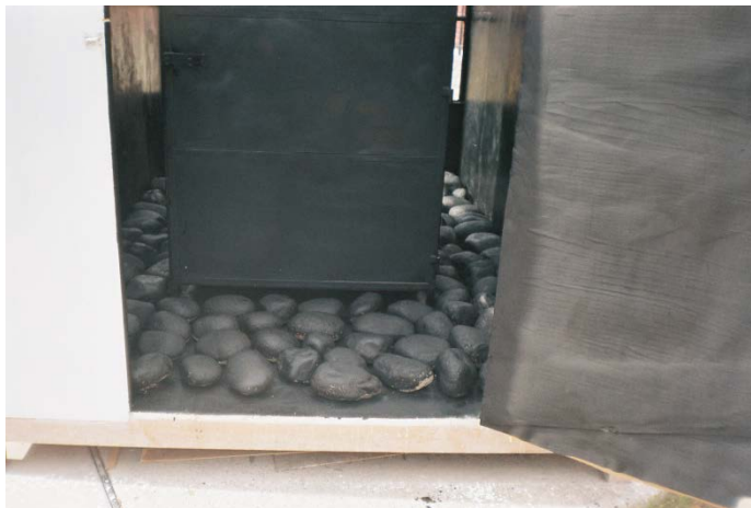
Figura 59: SSS como acumulador térmico la piedra pintada de negro mate.
