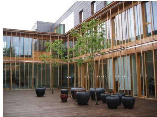
Figura 13. Vista de patio interior.
