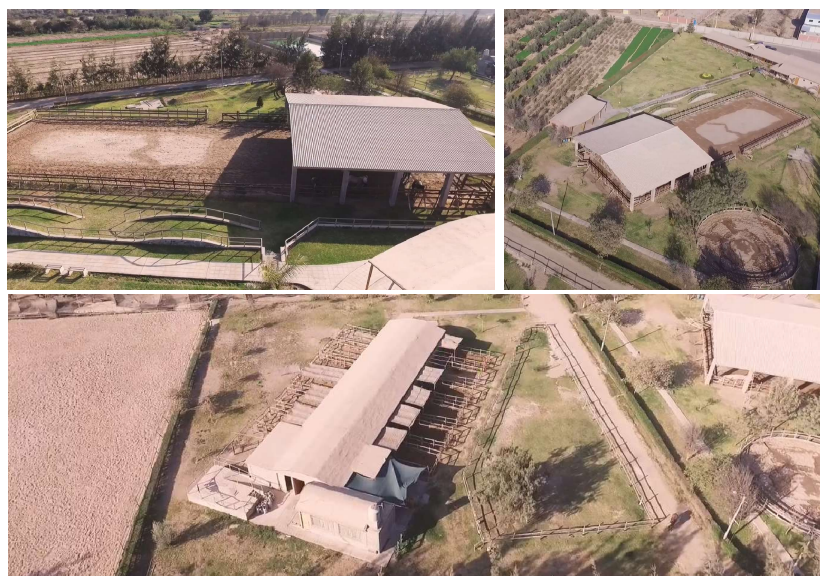
Figura 30. Instalaciones Centro de Equinoterapia Esperanza.
