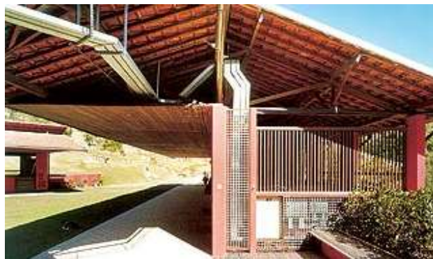
Figura 23. Instalación de rociadores. Fuente: http://www.arcoweb.com.br/
