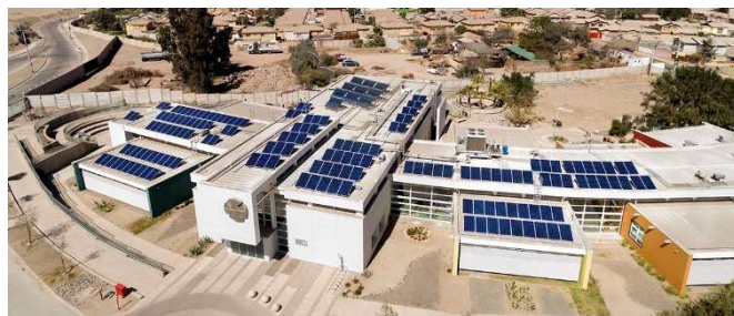
Figura 12. Uso de paneles fotovoltaicos.
