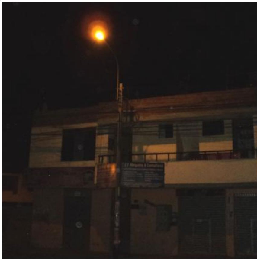
Figura 78: Alumbrado peatonal, av. Miraflores frente UNJBG
