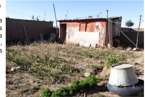
VIVIENDAS EN PROCESO DE CONSOLIDACION
