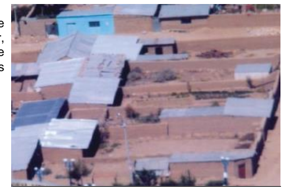
VIVIENDAS EN PROCESO DE CONSOLIDACION
