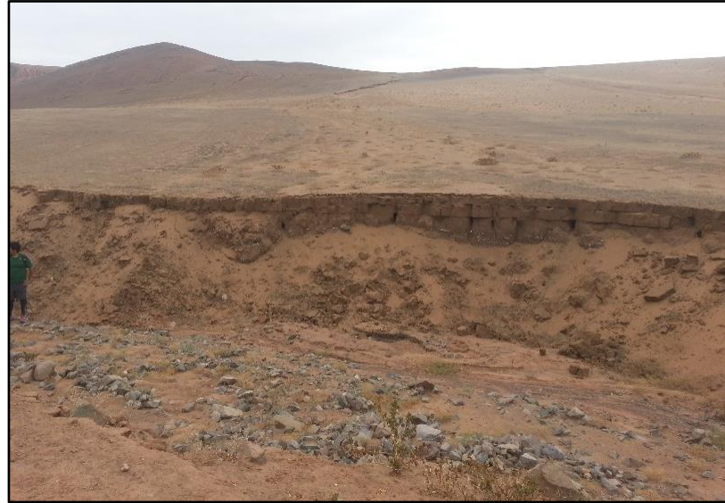
Figura 26. Terraza con una altura aproximada de 2m.
