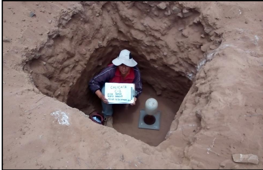
FOTO 01: Ensayo de Densidad In situ
