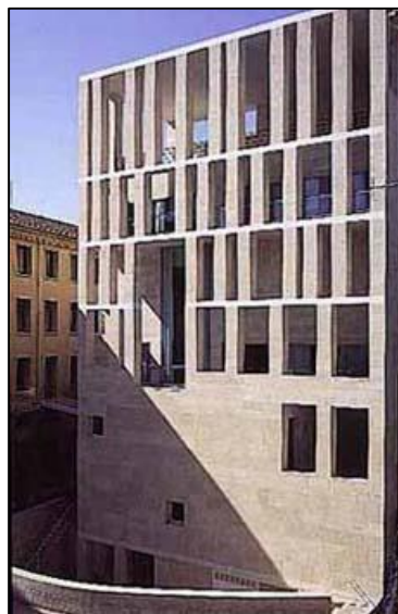
Figura 4. Vista de la Fachada Frontal
