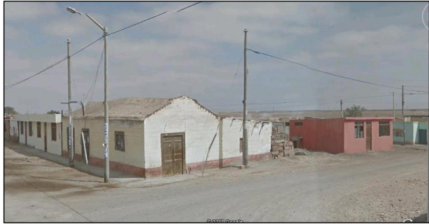
Figura 38. Vivienda de adobe
