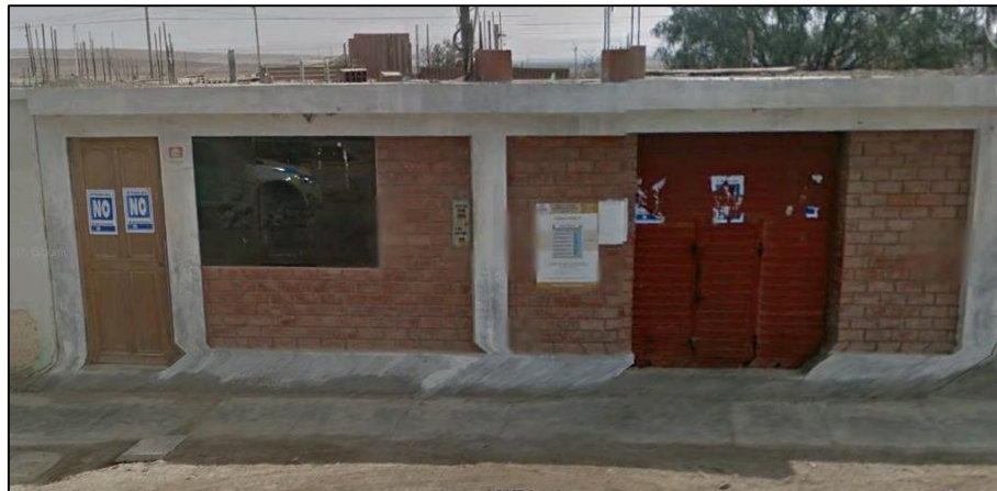
Figura 46. Vivienda de material de concreto
