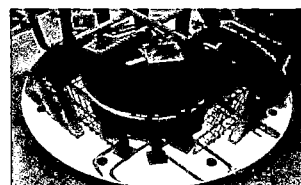
Aplicación e estructuración entre el Aislador de Base con las vigas de concreto
