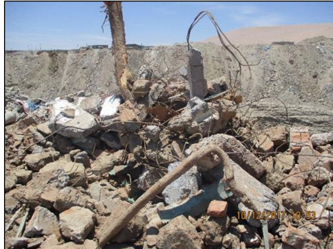
Figura 11. Fracciones obtenidas de un proceso selectivo de demolición.
