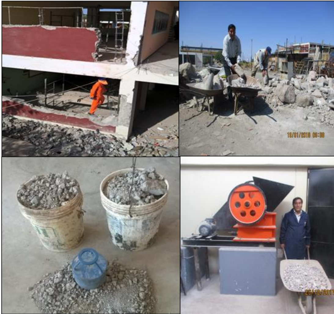
Figura 16. Obtención de agregado grueso reciclado de escombros de la C.U. UNJBG Fuente: Elaboración propia.
