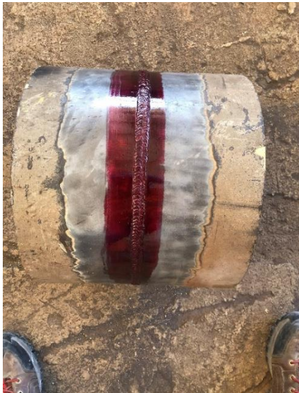
Figura 55: Aplicación de tinte penetrante. Fuente: Propio.
