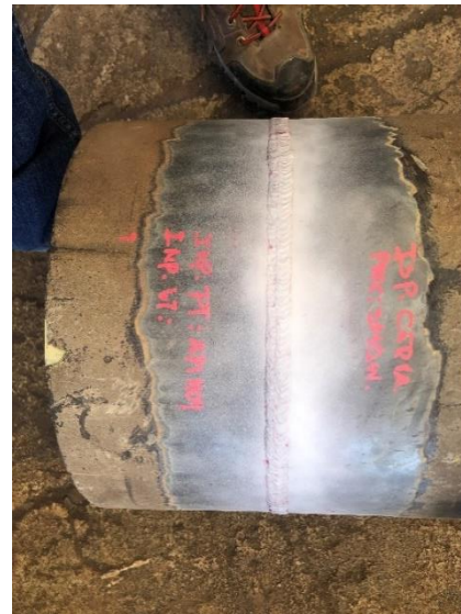
Figura 54. Inspección de acuerdo a API1104. Fuente: Propio.
