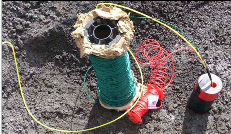
Figura 18. Instalación de cable resistivo junto al Booster y tubo de choque.
