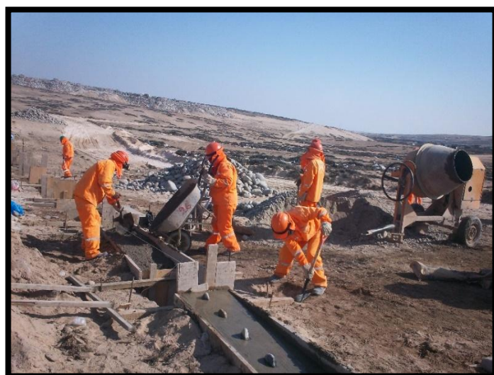
Figura N° 27: Trabajos de obra del relleno sanitario de Tacna.
