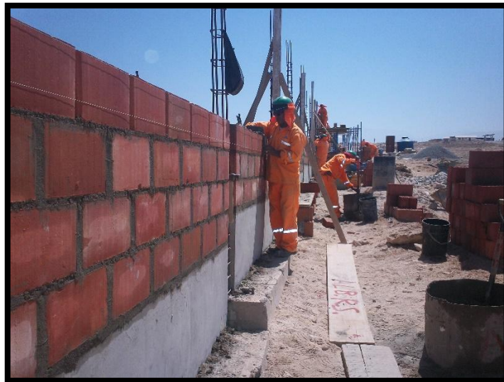
Figura N° 29: Obreros trabajando en la obra del relleno sanitario de Tacna
