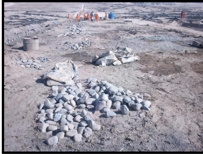
Figura N° 28: Obreros trabajando en la obra del relleno sanitario de Tacna.
