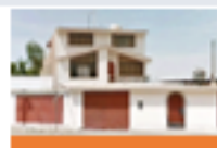
ESTADO BUENO: VIVIENDA DE 3 PISOS UBICADO EN LA AVENIDA 6
