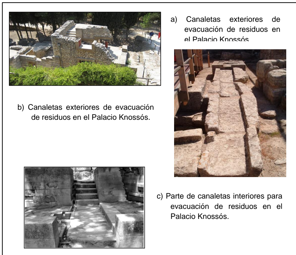
Figura 5: Fotos de los Sistemas de evacuación de aguas residuales urbanas diseñado por los antiguos griegos en la Isla Creta.
