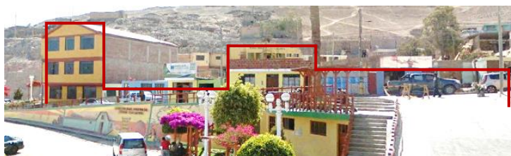
Figura 54. Perfil urbano de la Av. Circunvalación y calle Bolognesi. Producción propia (2018).
