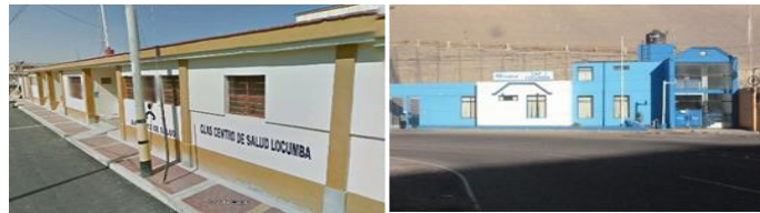
Figura 51. Centro de salud-posta médica ESSALUD. Producción propia (2018).
