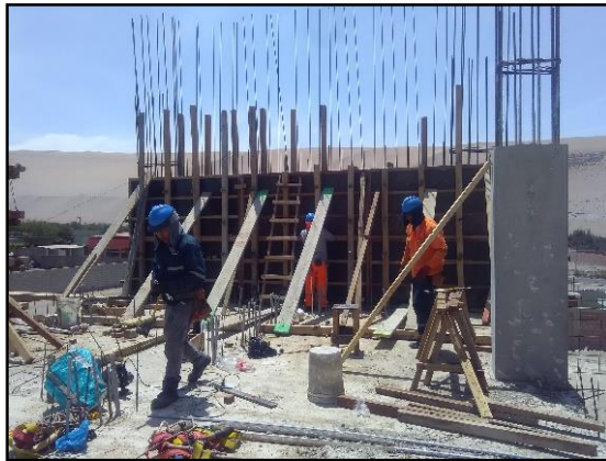
Fotografía 02. Encofrado de placas
