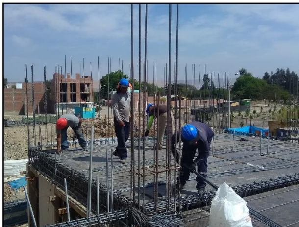
Fotografía 12. Colocación de acero en losa maciza
