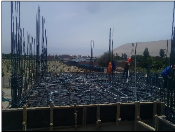
Fotografía 15. Techo de losa maciza lista para vaciado de concreto
