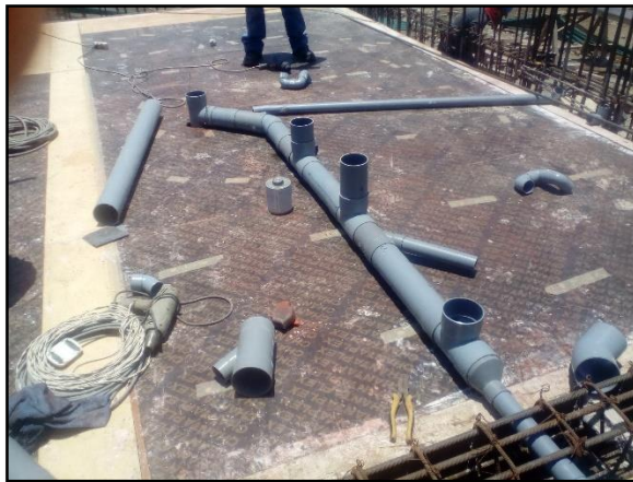
Fotografía 11. Instalaciones eléctricas en losa maciza (salida y entubado)
