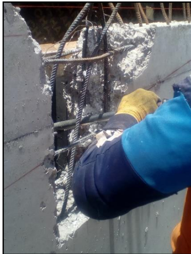
Fotografía 14. Retrabajos en muros (pase de vigas)
