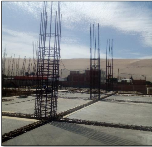
Fotografía 01. Colocación de acero en columnas
