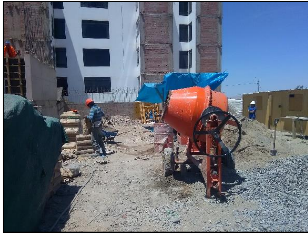
Fotografía 13. Preparación de concreto
