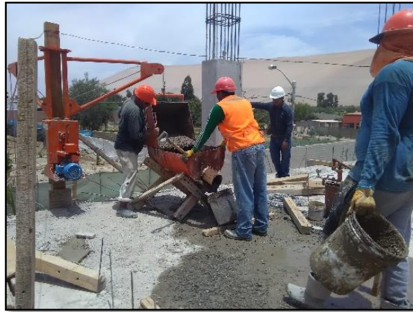
Fotografía 16. Transporte de concreto a pisos superiores
