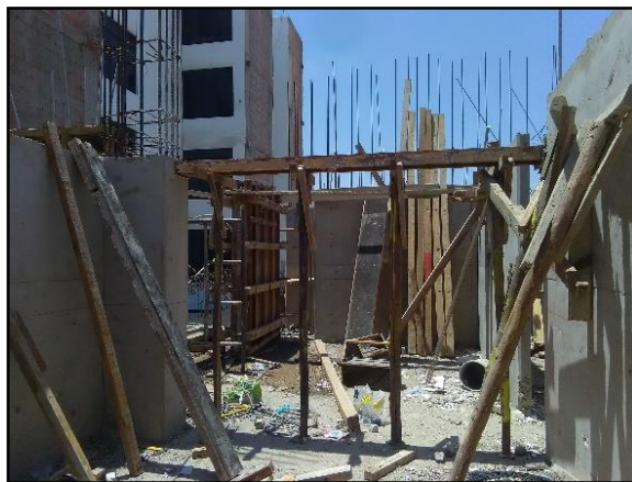
Fotografía 09. Encofrado en vigas
