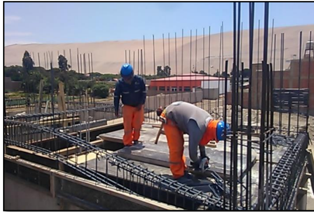
Fotografía 10. Colocación de acero en losa maciza
