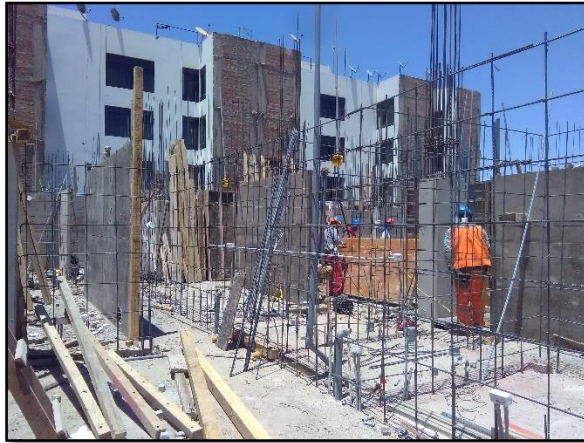
Fotografía 05. Colocación de acero en muros de cerramiento
