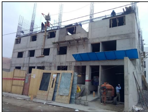
Fotografía 17. Edificación en construcción
