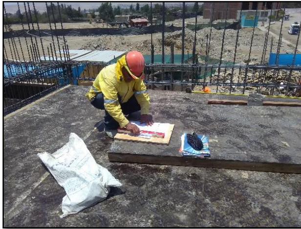
Fotografía 04. Trazado de muros de cerramiento
