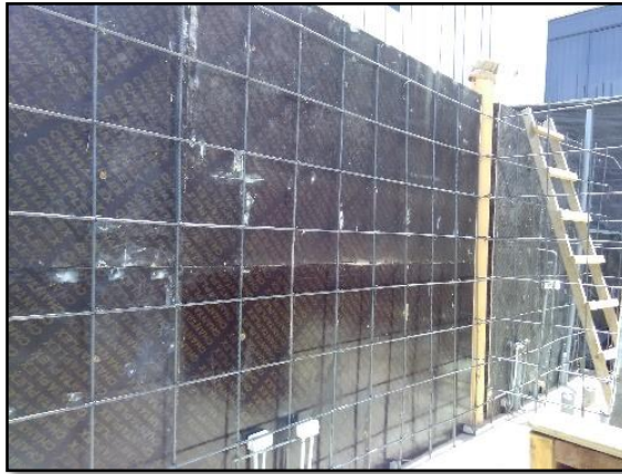
Fotografía 07. Encofrado de muros de cerramiento
