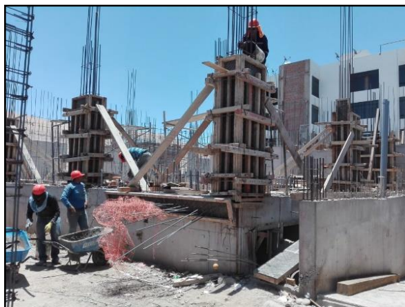
Fotografía 03. Colocación de concreto en columnas
