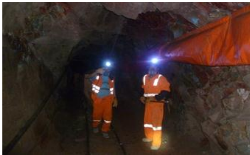
Figura 7. Instalación de mangas en galería, nivel principal
