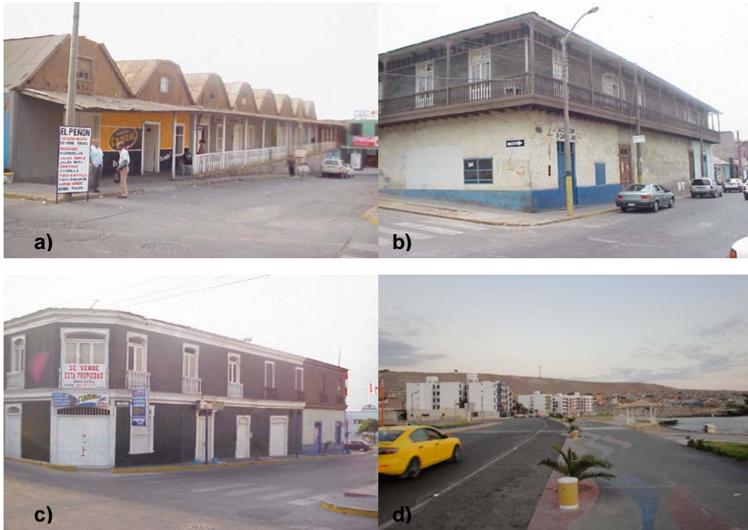
Figura I. a), b), c) Viviendas con piso de madera y con paredes de adobe o quincha, y d) Edificios residenciales de 06 pisos ubicados en el área de inundación
