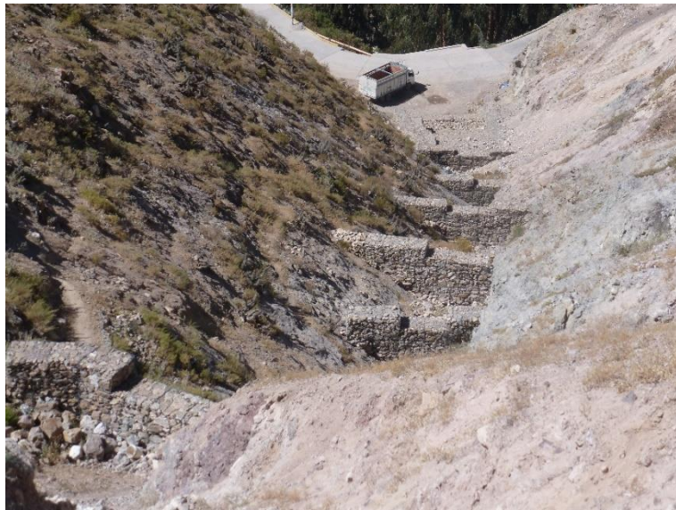
Fotografía N°19: Sistema de diques en la quebrada Llusta Cahua.
