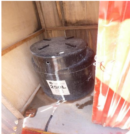
Figura 16: Tanque donde se prepara la solución desinfectante Fuente: Elaboración propia, 2015
