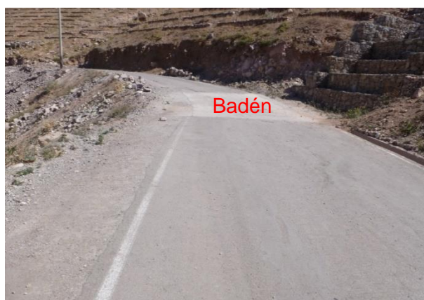
Figura 26: Obras de protección con concreto Fuente: Elaboración propia, 2015
