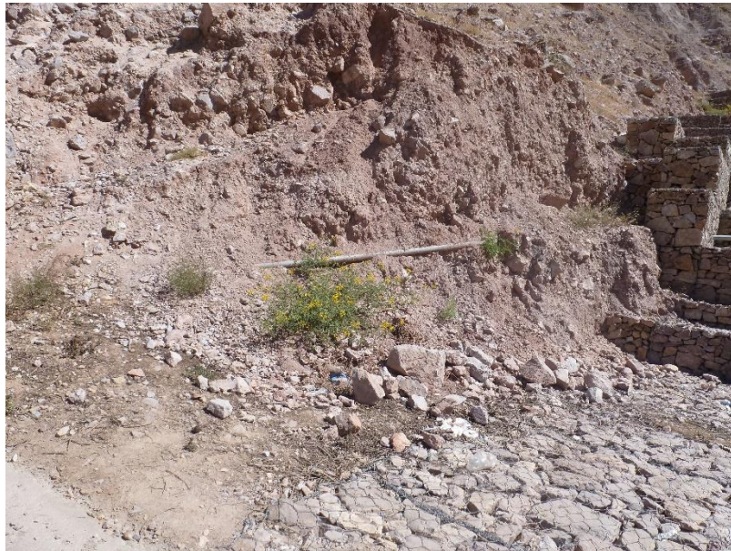
Fotografía N°16: La red de distribución de agua potable se encuentra expuesta en la calle nueva visión próxima a la quebrada Alta Misa.
