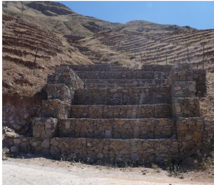
Fotografía N°17: Diques de protección en las quebrada Uyara.
