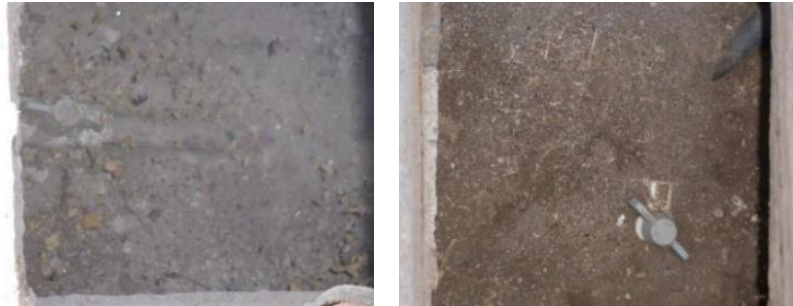
Figura 15: Conexiones domiciliarias Fuente: Elaboración propia, 2015
