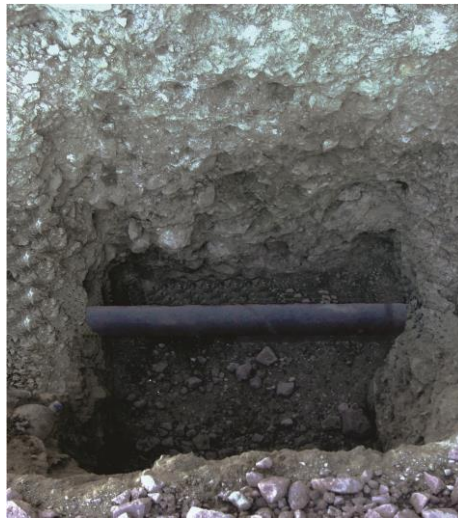
Fotografía N°14: La inspección de la red de distribución de agua potable, en la calle el Mirador.
