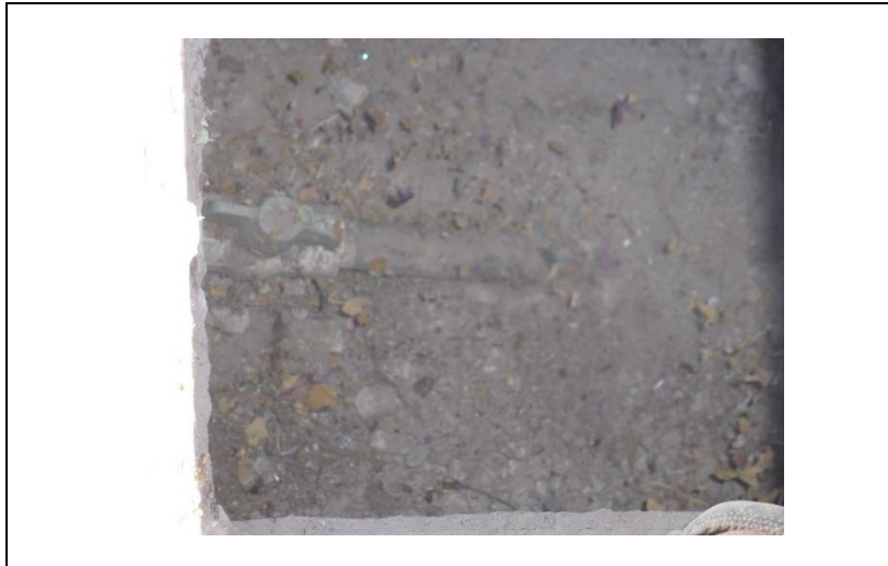
Fotografía N°07: Las cajas de conexión de agua potable no cuentan medidor.
