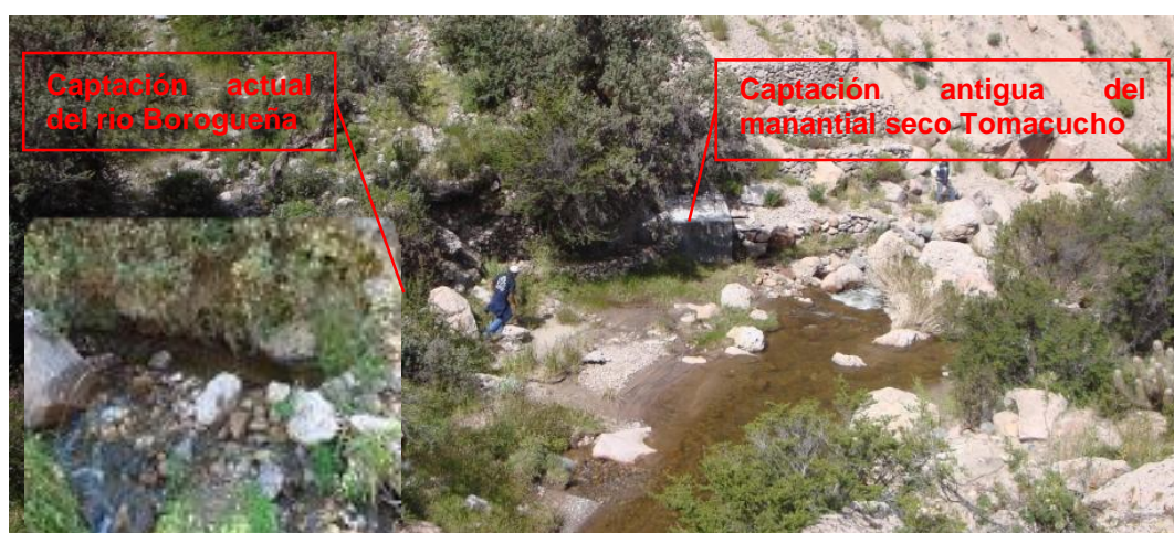
Figura 6: Captación Tomacucho Fuente: Municipalidad Distrital de Ilabaya, 2012
