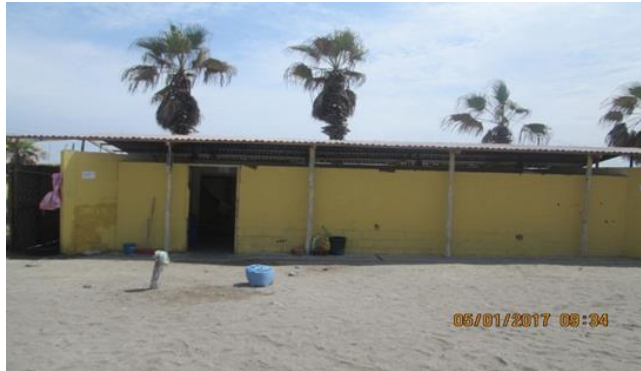
Figura No. 75. Vista exterior de SSHH – Duchas
