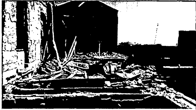
IMAGEN N° 57 VISTA DEL SEGUNDO NIVEL, DE LA FACHADA AV. SAN MARTIN
