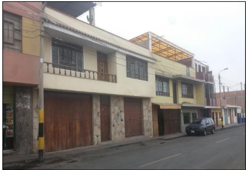
Figura N° 25. Viviendas unifamiliares consolidadas Calle Uruguay.
