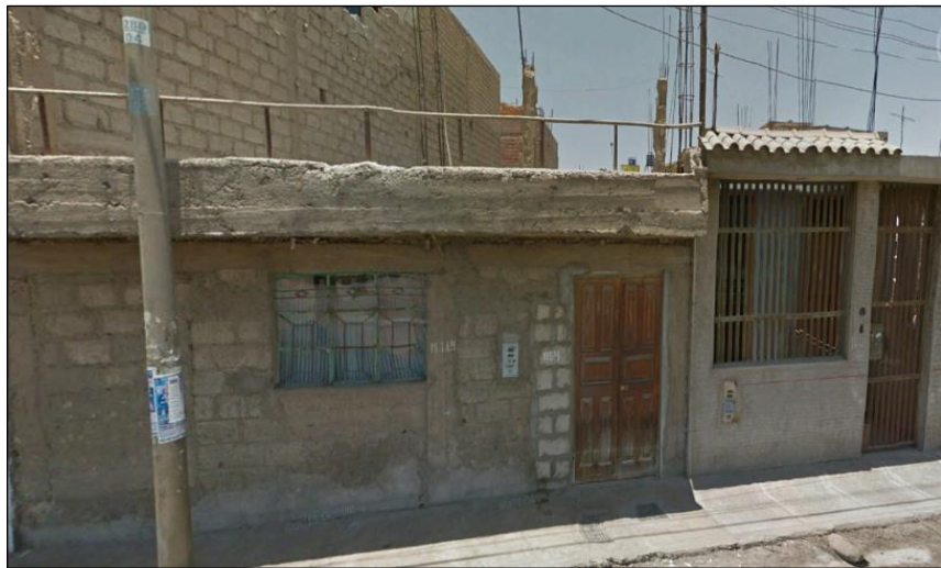
Figura N° 35. Estado de edificación Av. Industrial.
