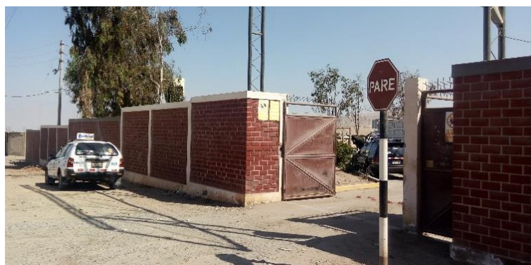
Figura N° 28. Vista exterior del Matadero Municipal Mario Eyzaguirre Yañez.
