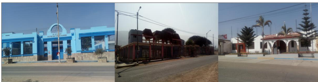
Figura N° 54. Edificación con sistema aporticado. Fuente: Fotografía propia.
