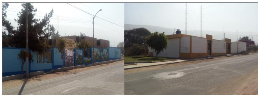
Figura N° 53. Edificación de albañilería confinada. Fuente: Fotografía propia.
