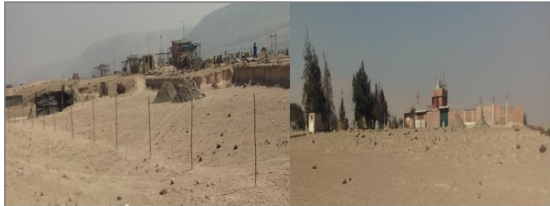
Figura N° 56. Edificación de material rústico.
