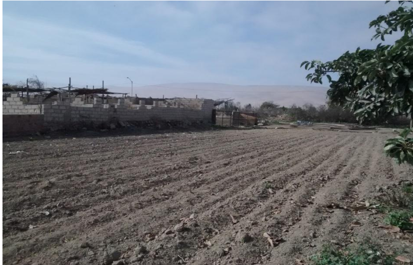
Fotografía 02. Preparación del terreno
