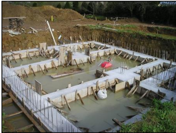
Figura 88. Sistema de vigas de cimentación.
