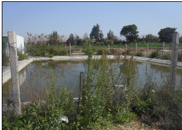
Figura 17. Casa del Agricultor - Reservorio
