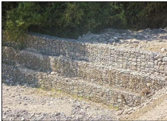
Figura 124. Muros de contención en Moquegua por la Empresa Cidelsa con Gaviones colchón y caja.
