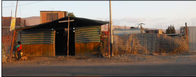
Figura 70: Edificación con Madera y de Estera
