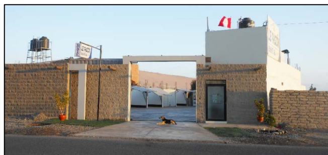
Figura 69. Edificación con Ladrillo o Bloque de Cemento
