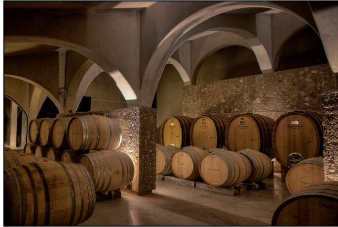
Figura 107. Columnas y Vigas Bodega Zuccardi Valle de Uco
