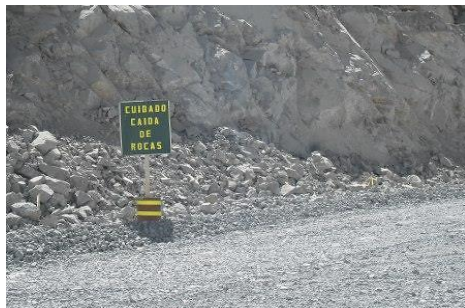
Foto de la zona de accidente, se puede apreciar el aviso preventivo de peligro.
